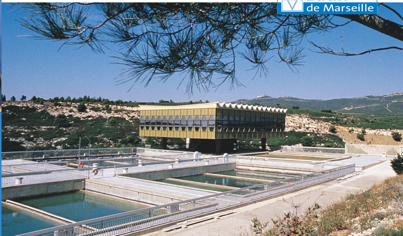
Vue du centre de production de Vallon Dol
