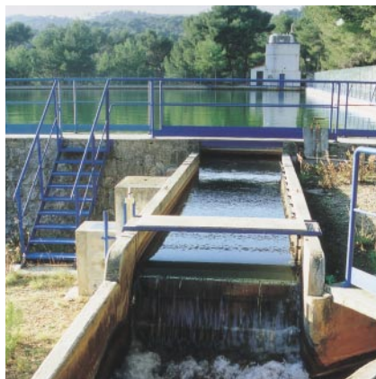
Arrivée de l'eau du canal
