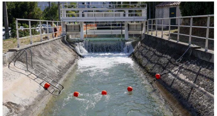
Des lignes de vie et des échelles sont installées partout le long du canal là où il y a des obstacles. Mais les utiliser pour sortir de l'eau n'est pas aisé. / PHOTO FRÉDÉRIC SPEICH
