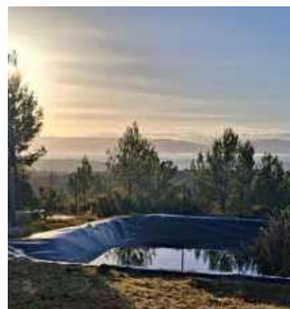
Le plan d'eau du centre de production d'eau potable des Sauvets.
